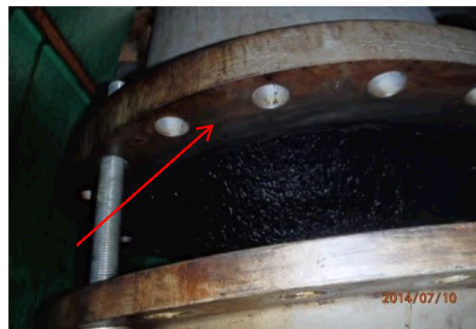
Foto 8 Hier is de pakking verwijderd
