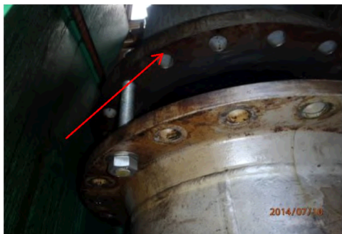
Foto 7 Hier is de pakking verwijderd
