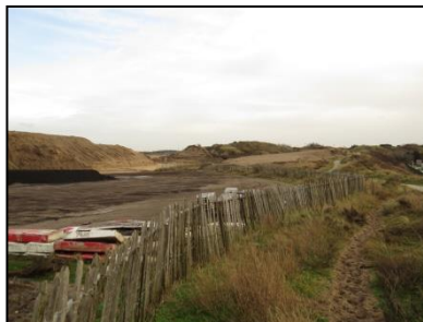
Figuur 5. Fanzone, overzicht gronddepot in de verte
