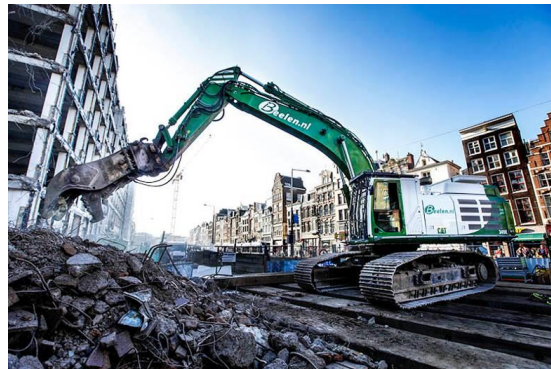
Puin vergruizen op maaiveld
