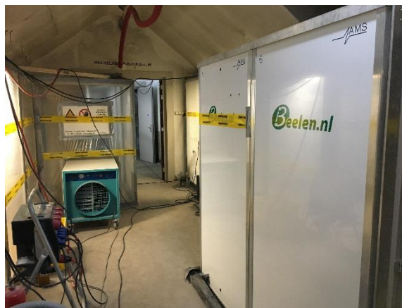
Containment t.b.v. asbestsanering
