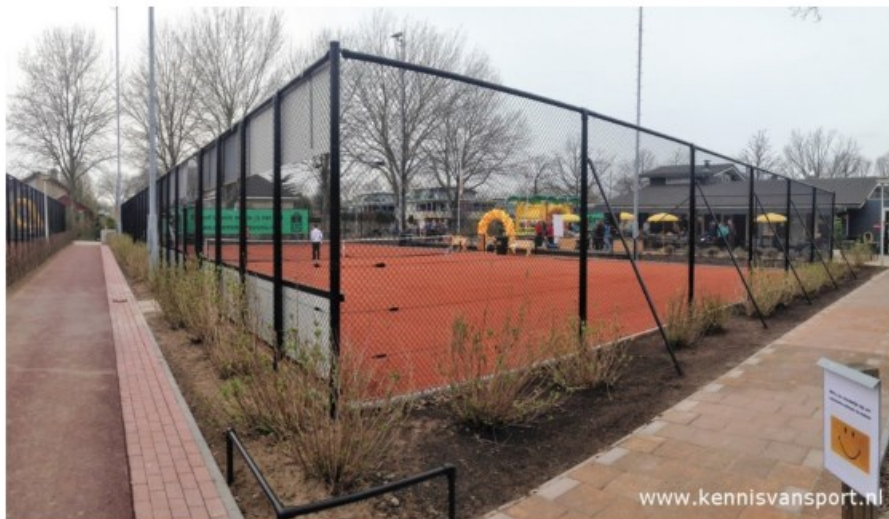
principe gaashekwerk 3,00 meter hoog
