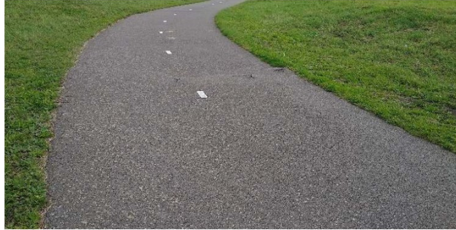
Foto 84 Verzakkingen in het asfalt
