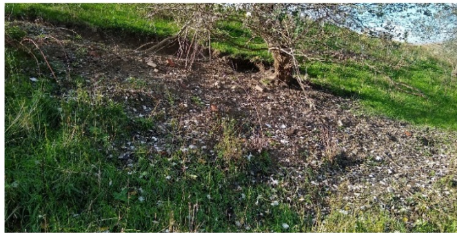
Foto 87a verschuiving in talud
