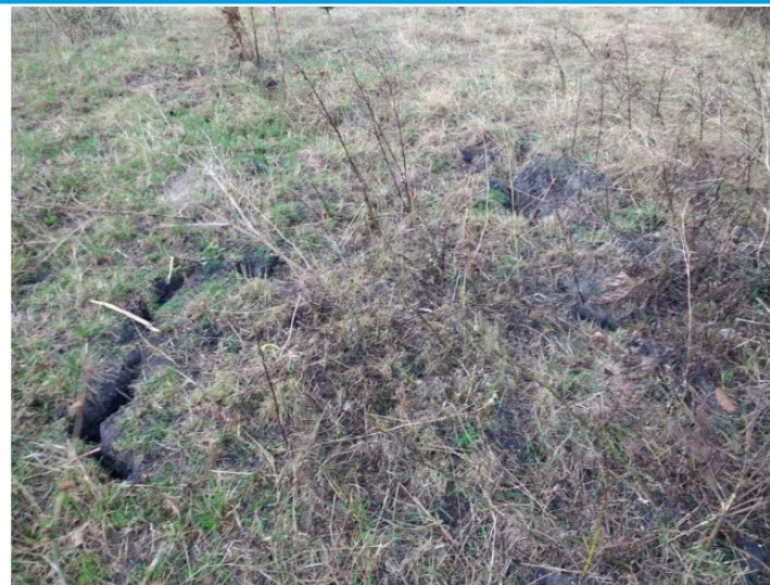
Foto 12. Scheuren in talud wielerbaan
