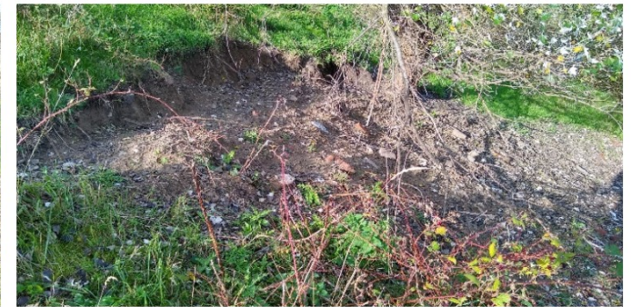
Foto 87b verschuiving in talud
