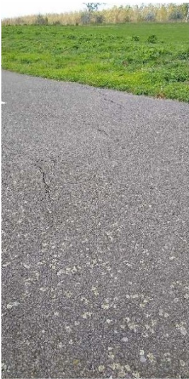
Foto 86 fietspad bobbels en scheuren
