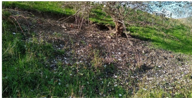
Foto 87a verschuiving in talud
