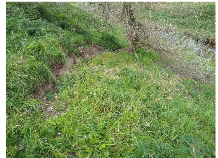
Foto 54: 87c verschuiving in talud
