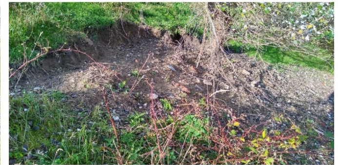
Foto 87b verschuiving in talud
