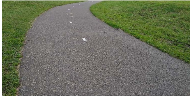
Foto 84 Verzakkingen in het asfalt
