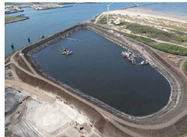
Toezicht Averijhaven IJmuiden vanuit de lucht
