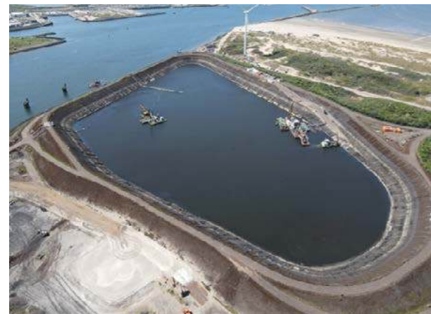
Toezicht Averijhaven IJmuiden vanuit de lucht
